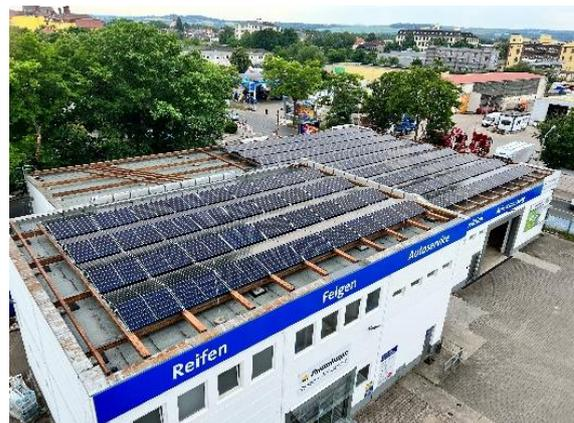
Diese Investitionen umfassen sowohl die Komponenten der PV-Anlage, zu denen die Solarmodule, die Wechselrichter und die Montagegestelle gehören, als auch die notwendigen vorbereitenden Maßnahmen wie z.B. die Ertüchtigung der Statik und die Dachabdichtung, um eine langfristige Sicherheit und Effizienz der Solaranlagen zu gewährleisten.
